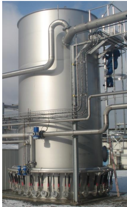
Σχήμα 4. Δεξαμενή βιοφίλτρανης SMBF που εξυπηρετεί 3.000 ισοδύναμους κατοίκους
